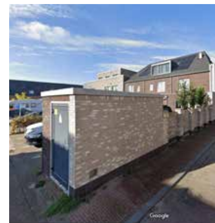
Technische ruimte in bouwblok
