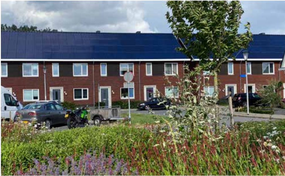
zonnepanelen in dakpannen - De Gaarden, Deest
