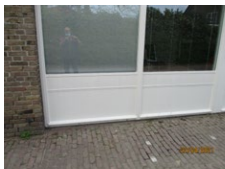
Asbest kozijnpanelen
